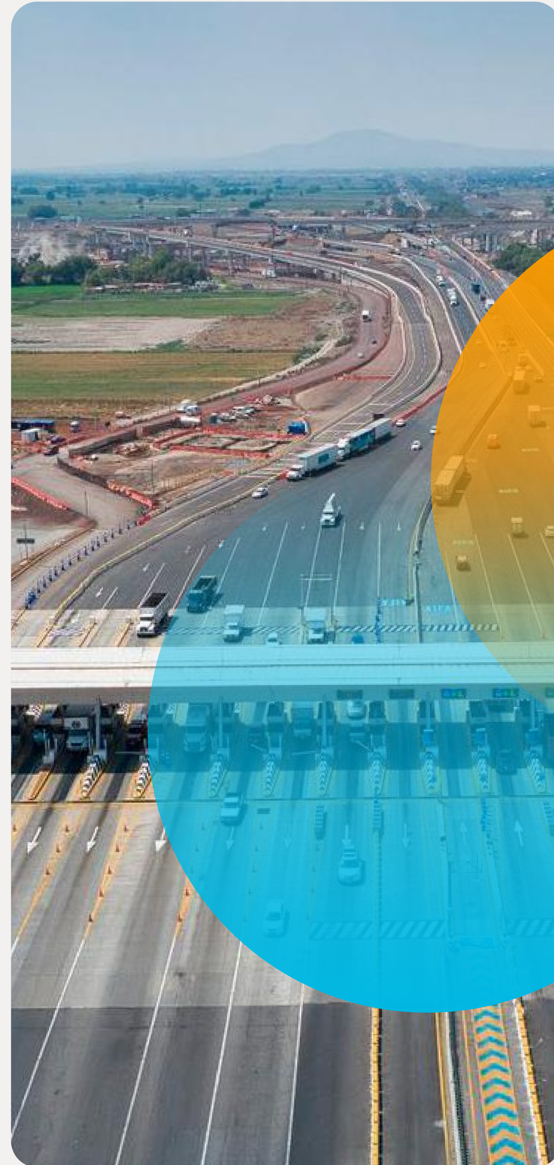
Circuito Exterior Mexiquense
