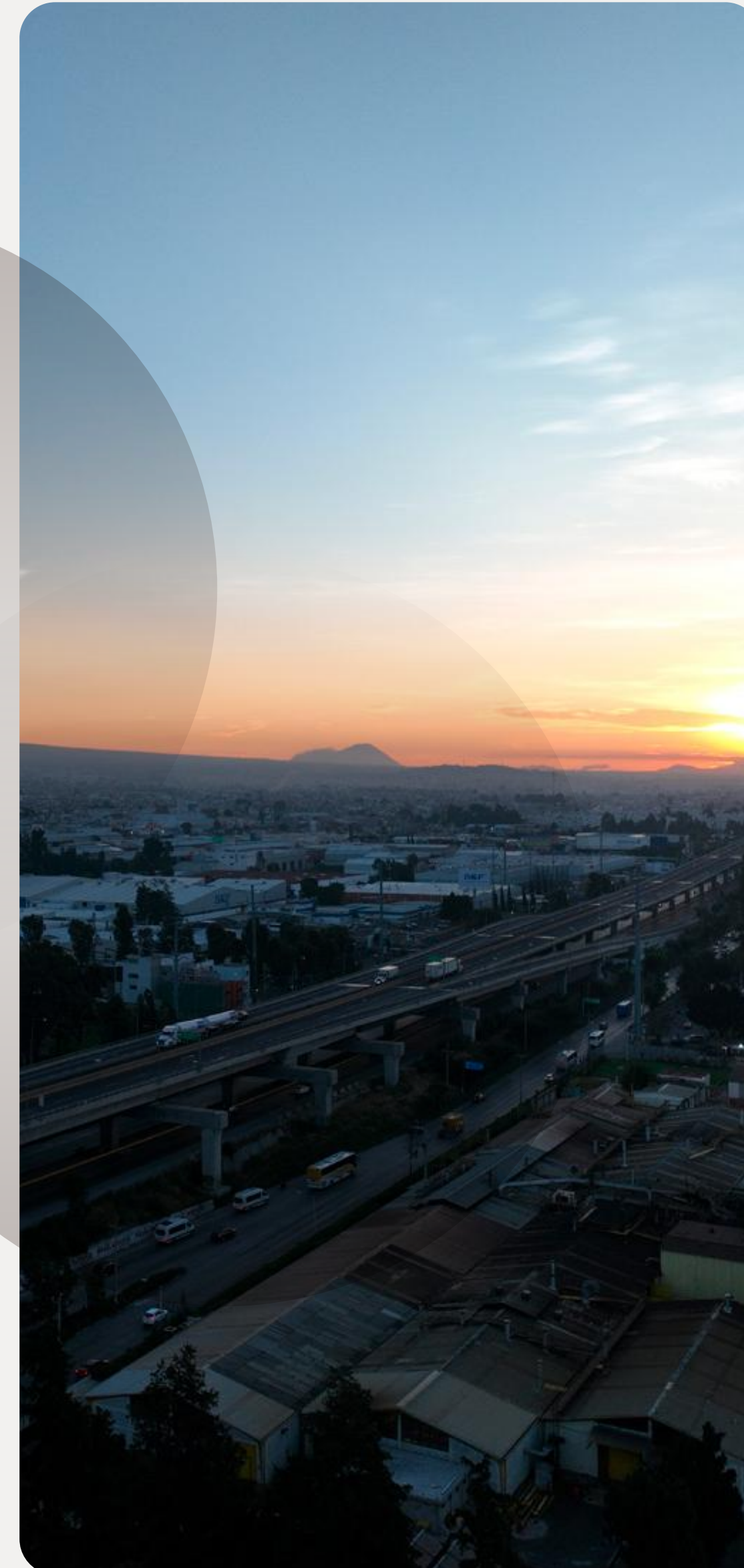
Libramiento Elevado de Puebla
